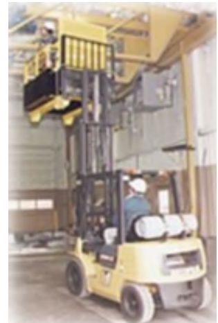
Auf den Gabeln eines Flurförderzeuges angehobene Arbeitsbühne
