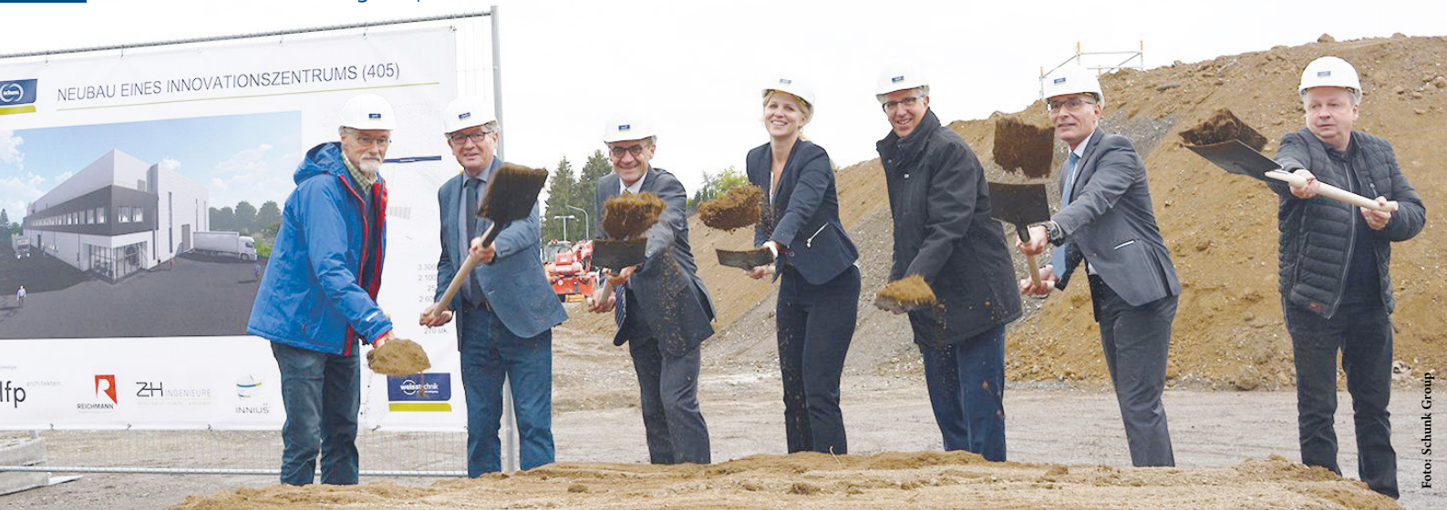
Machten gemeinsam den symbolischen ersten Spatenstich für das neue Innovationszentrum (von links): Reinhard Bösser (Firma Hinterlang), Dr. Manfred Ehlers (Erster Beigeordneter Gemeinde Heuchelheim), Dr. Stefan Schneewis, Claudia Moser (blfp architekten), Dr. Arno Roth, Bernd Siegmann und Arno Pfeiffer (Firma Hinterlang).
