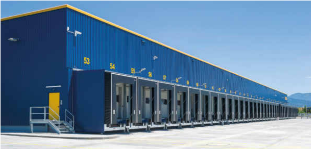
Der neue Standort von Dachser in Eschbach.
