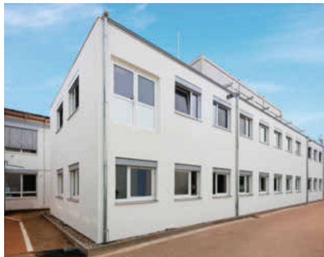
Der neue Anbau von „VascoMed“ in Binzen.
