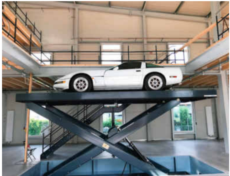
Eine hydraulische Hebebühne erschließt den Parkraum im Obergeschoss.
