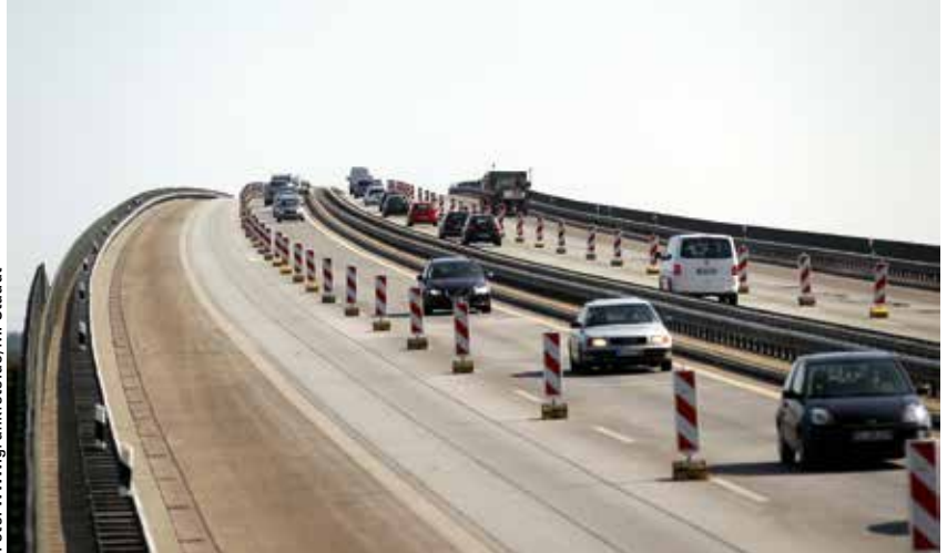
Unbefriedigend: Noch ist die alte Rader Hochbrücke in Betrieb.
