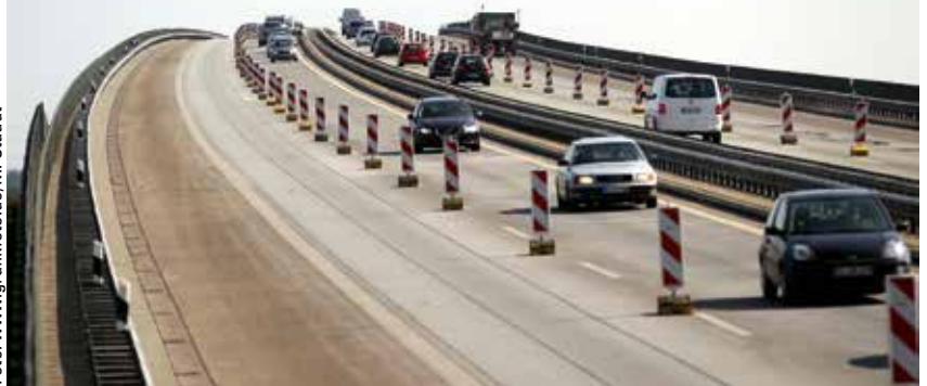
Unbefriedigend: Noch ist die alte Rader Hochbrücke in Betrieb.
