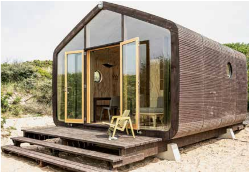
Innovation für die Helgoländer Düne: Wickelhouse aus vier Modulen
