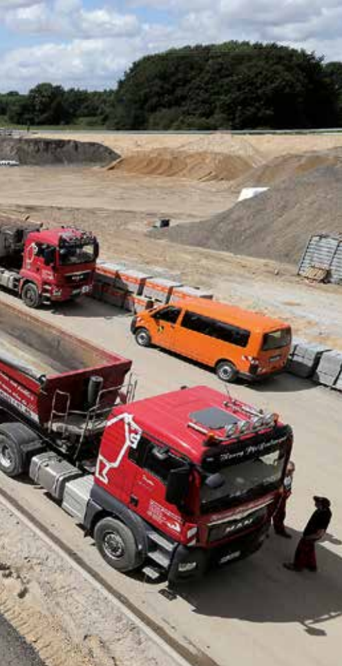
Ausbau der B 404 zur A 21
