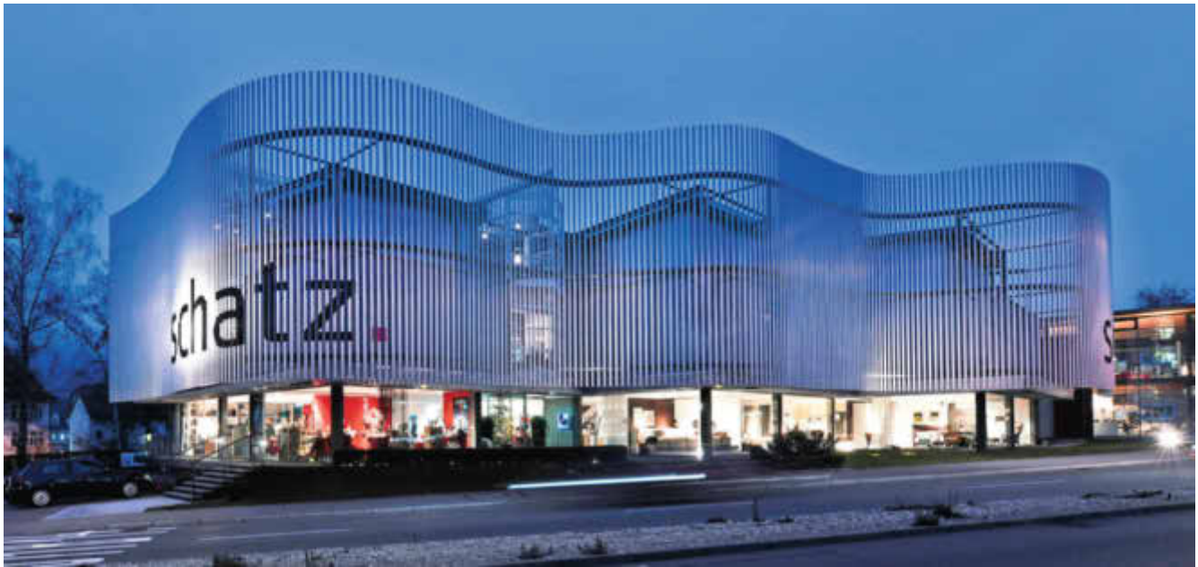
Das augenfällige Geschäftshaus von Schatz am Tuttlinger Aesculap-Platz.
