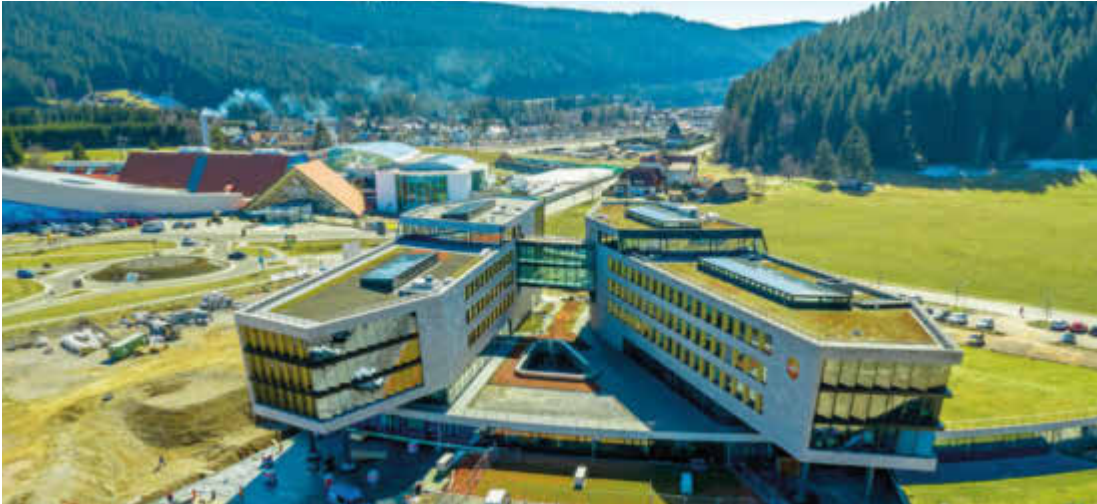
Jetzt sind es Zwillinge: Der zweite von insgesamt vier geplanten Bauabschnitten am neuen Firmensitz von Testo in Titisee wurde fertiggestellt.
