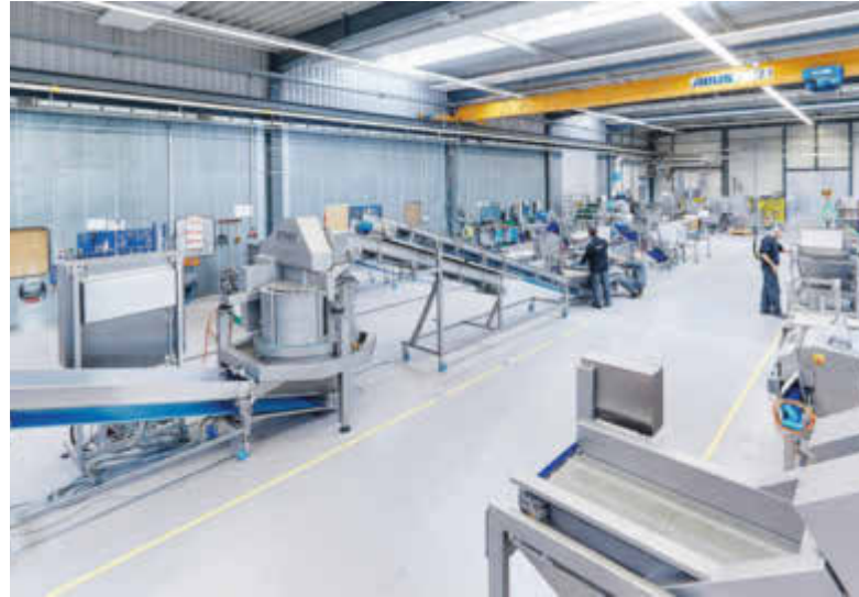
Kronen investierte vergangenes Jahr in den Umbau der Sonderbaumontage.
