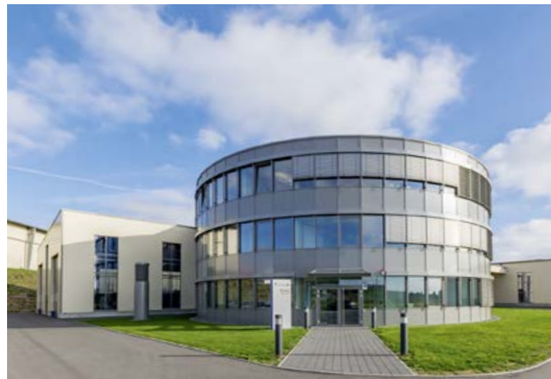
R&amp;D Center der Systemair GmbH in Windischbuch
