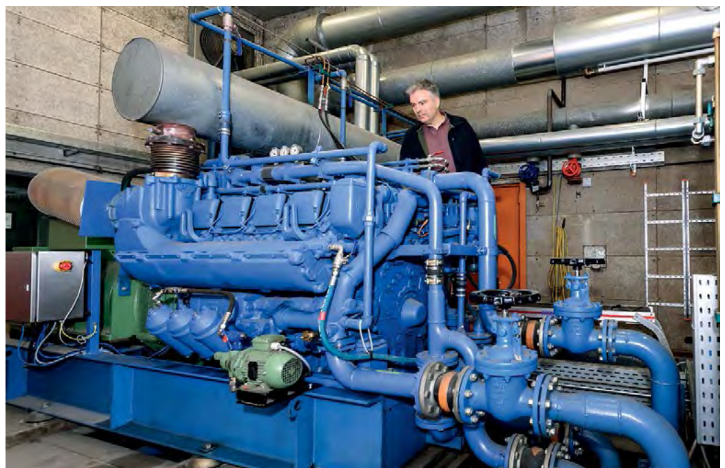
Eine Netzersatzanlage sorgt für reibungslose Abläufe im Klärwerk.
