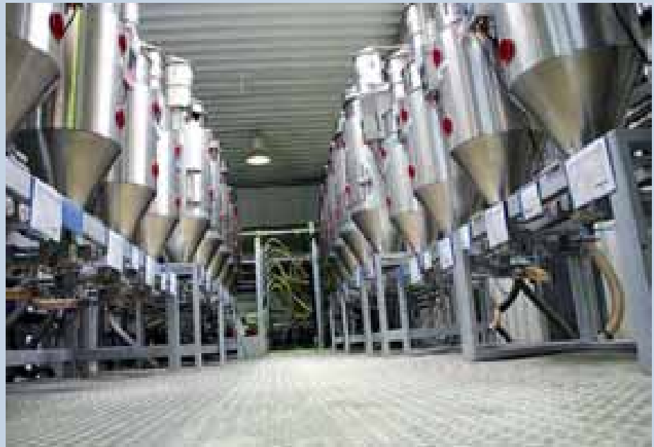
Hier wird Granulat getrocknet und gelagert
