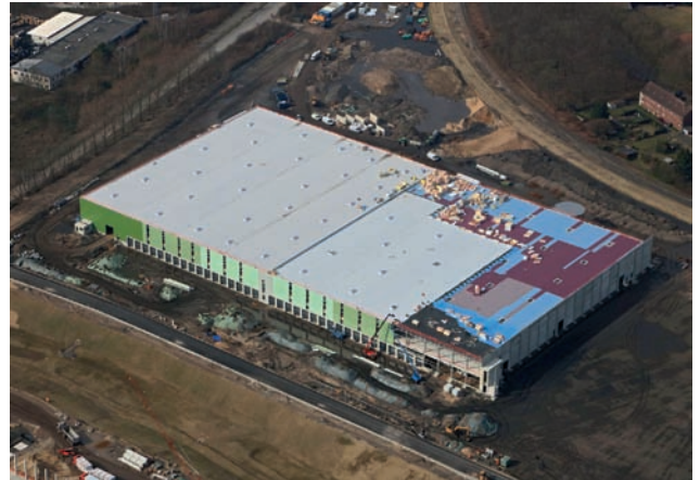
In Kamp-Lintfort errichtet die Habacker Holding ein Logistikzentrum für das E-Commerce-Unternehmen Chal-Tec. Foto: Goldbeck
