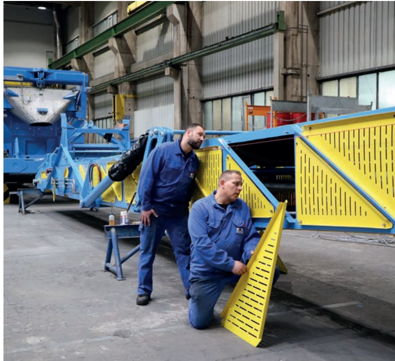
Torsten Phillip (links) und Dirk Mensen inspizieren Teile eines Schiffbeladers, der in den Hallen von Aumund in Rheinberg montiert wird. Foto: Aumund
