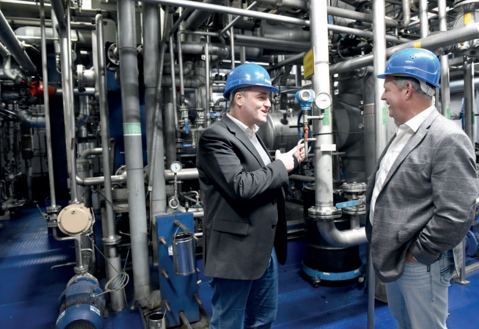
Guido Schmidt (links) und Bernd Dörlicher in der Destillationsanlage.
