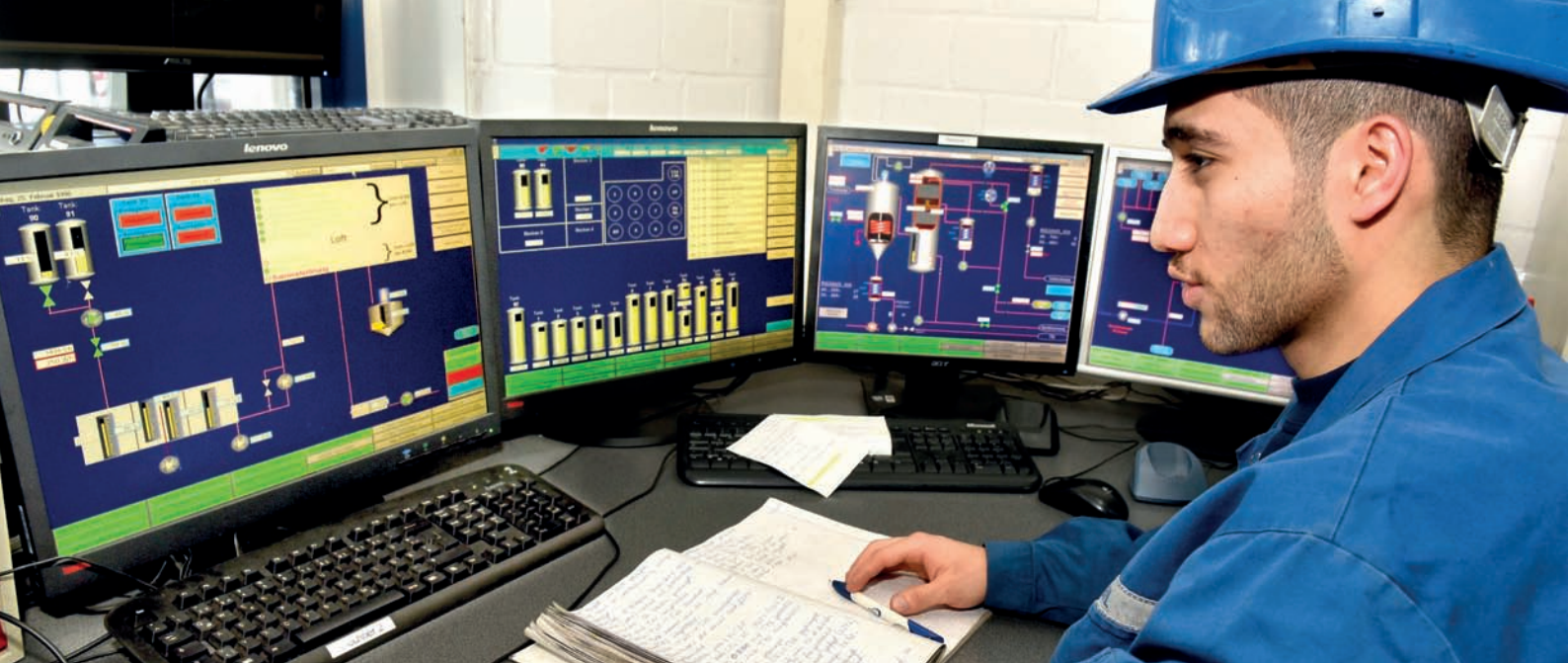
Mitarbeiter Benyamin Bol in der Leitwarte der Sonsbecker Anlage.
