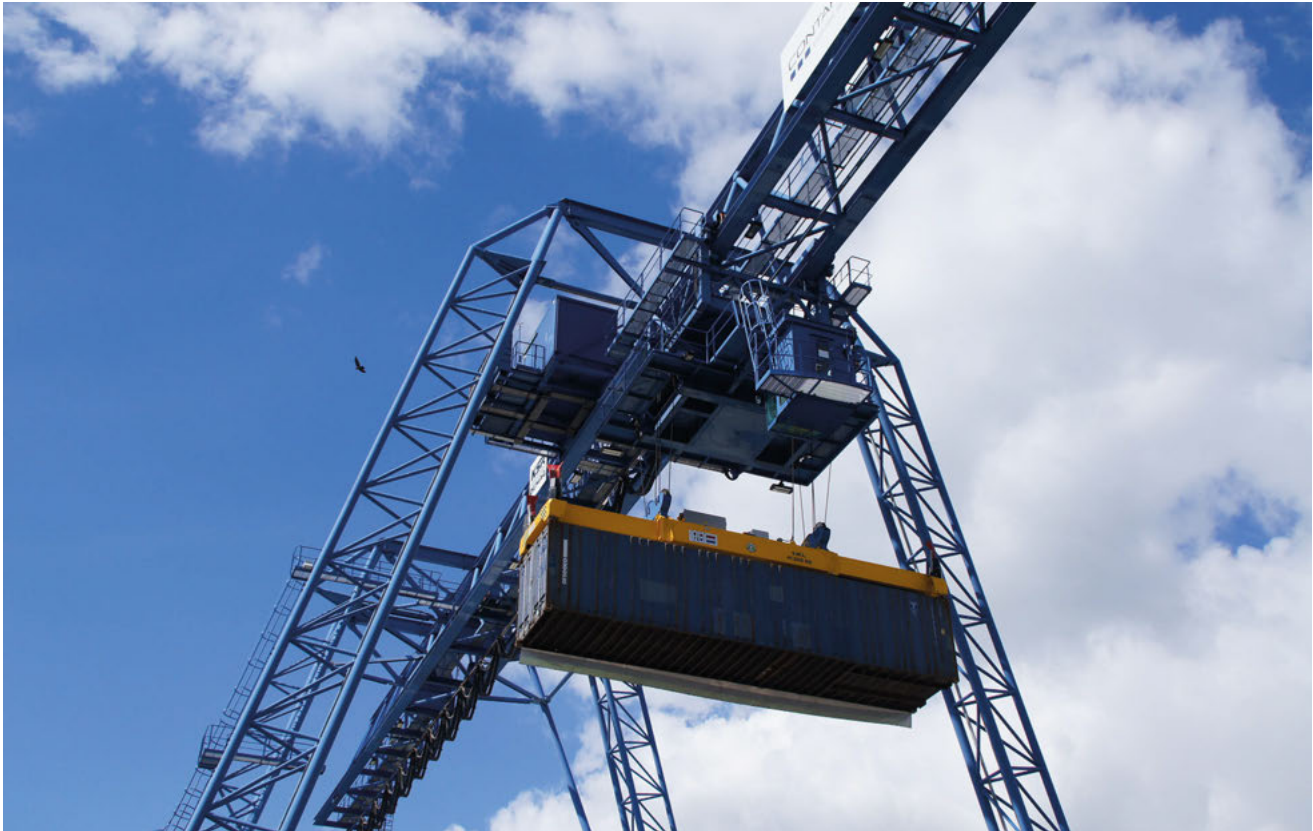
Contargo eröffnete am Tag der Logistik das neue Terminal in Emmelsum-Voerde.
