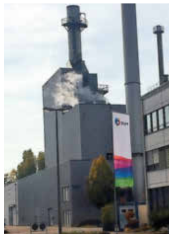
Das neue Dampfturbinenkraftwerk von DSM in Grenzach.
