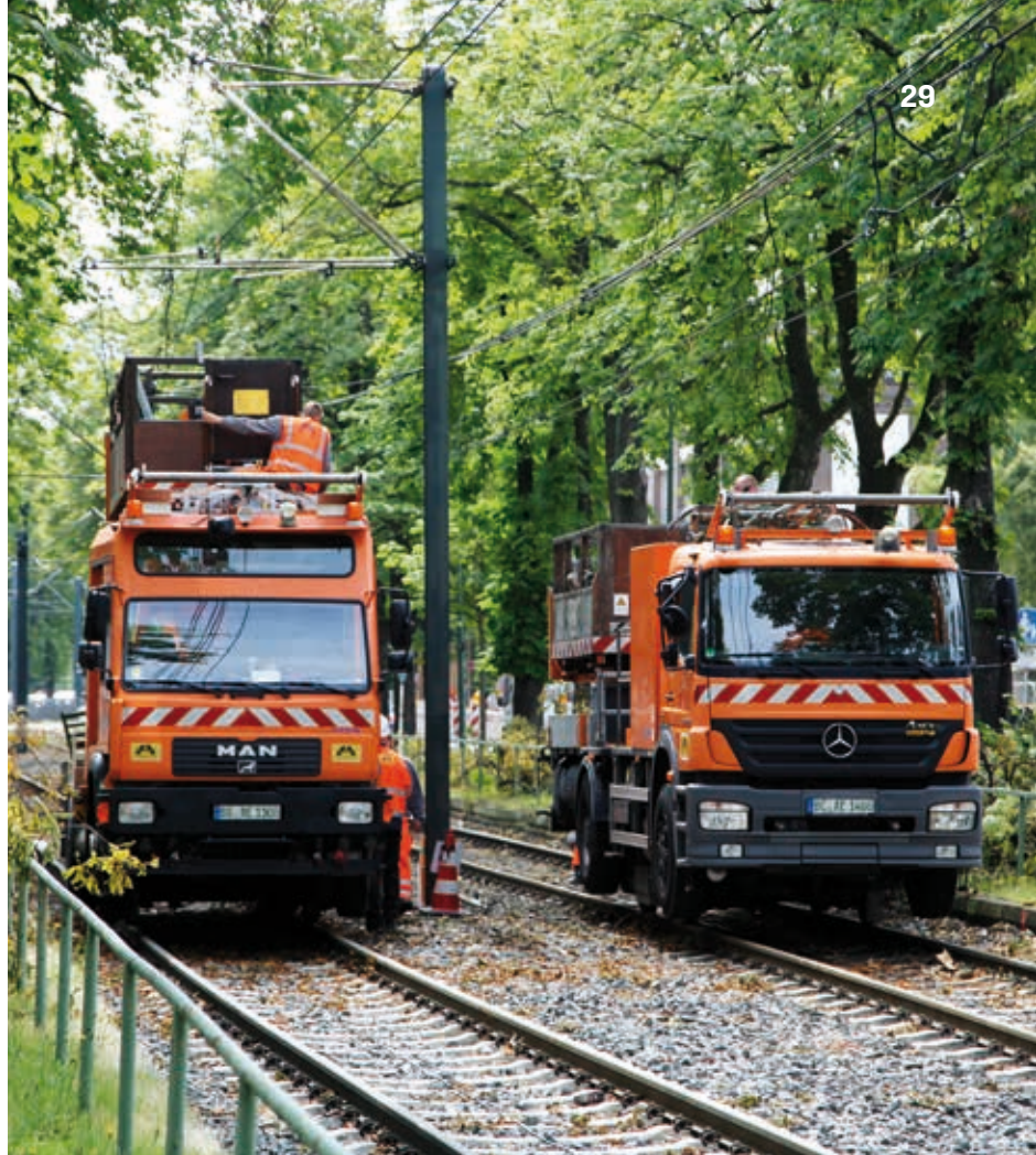
Mit sogenannten „Turmwagen“ beseitigen Mitarbeiter der Rheinbahn zum Beispiel auch Sturmschäden an den Oberleitungen.
