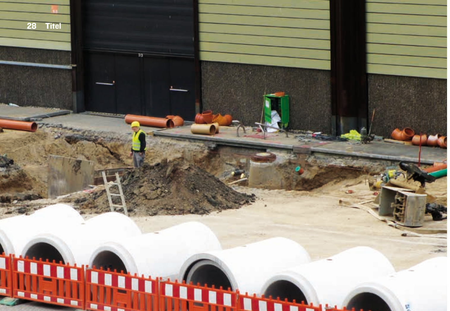
Umbau der Kanalleitungen bei der Messe Düsseldorf.
