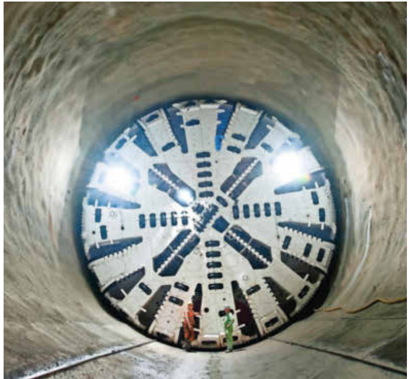
Die Tunnelbohrmaschine „Suse“ hat Ende Juli die Weströhre des Fildertunnels vollständig aufgefahren, jetzt folgt die 3,4 Kilometer lange Oströhre. Der Fildertunnel ist der längste Tunnel der neuen Bahnstrecke zwischen Stuttgart und Ulm.
