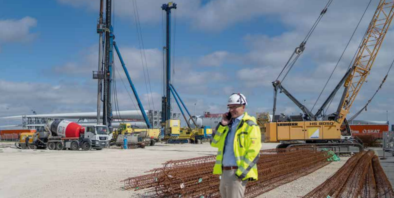
CEO Heiko Mützelburg auf der Firmenbaustelle
