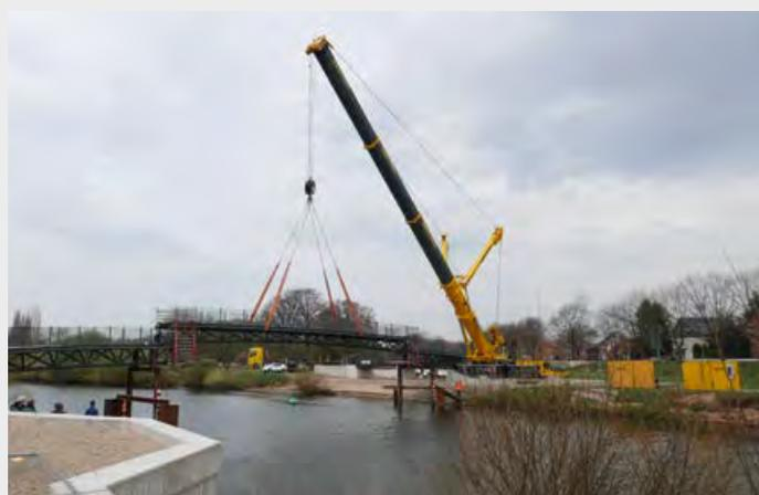
Die Montage des 31 Meter langen und mehr als 23 Tonnen schweren Mittelstücks erfolgte mithilfe eines 500-Tonnen-Krans.
