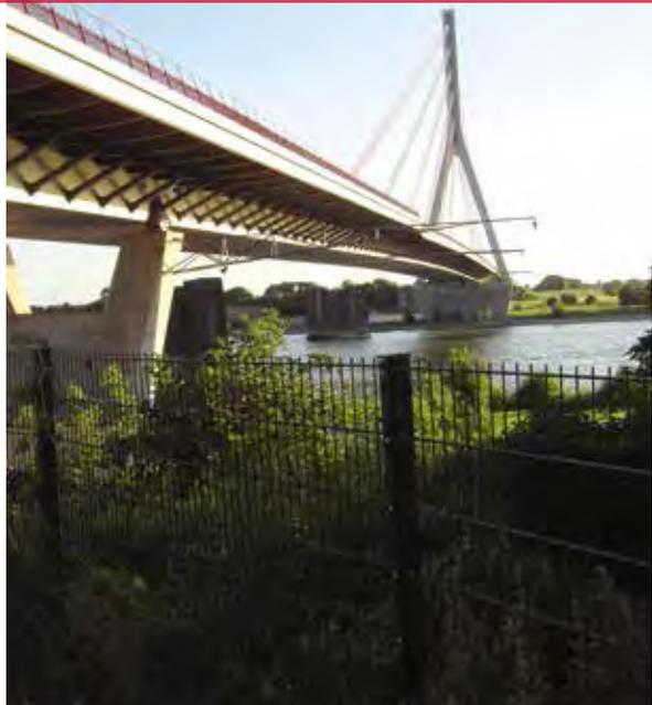
Der Brückenzug überführt die B 58 und hat auf mehr als 770 Metern vier Fahrstreifen und auf beiden Seiten Geh- und Radweg.
