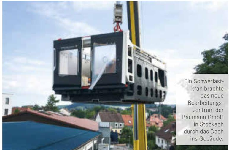
Ein Schwerlastkran brachte das neue Bearbeitungszentrum der Baumann GmbH in Stockach durch das Dach ins Gebäude.
