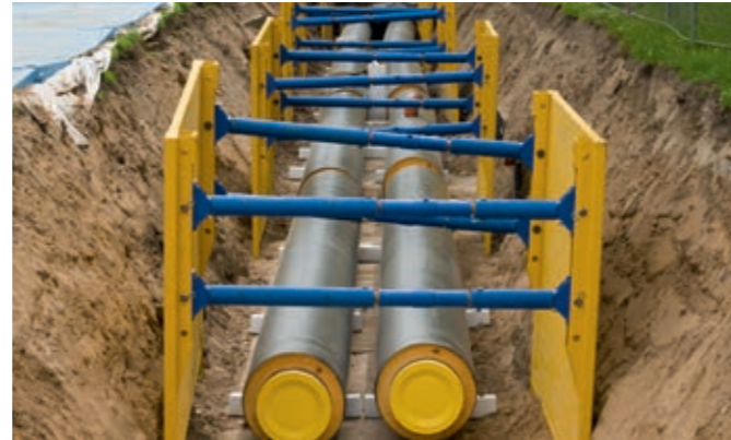
Verlegung einer neuen Wärmeleitung mit zwei Leitungssträngen (Bild: iStock by Getty Images)
