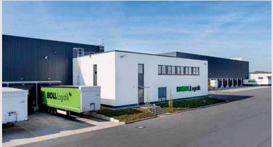
Die neue Halle verfügt über eine Nutzfläche von rund 10 000 m 2 .
