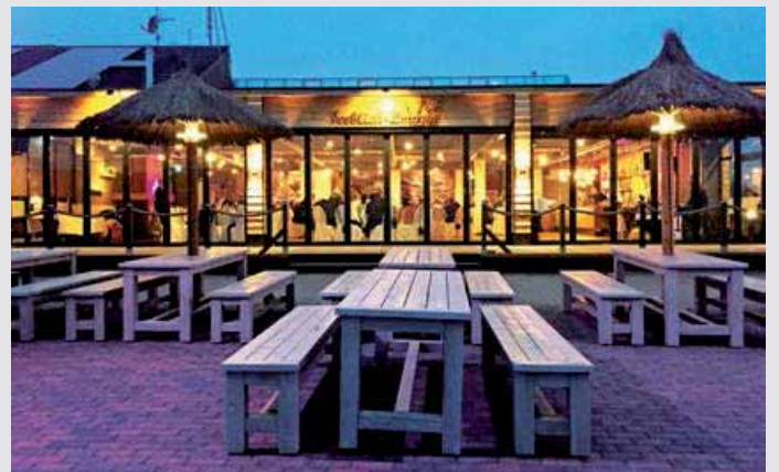
Durch den Umbau der Gastronomie „Deichkrone“ hat das Umfeld am Speichersee Geeste stark an Attraktivität gewonnen.
