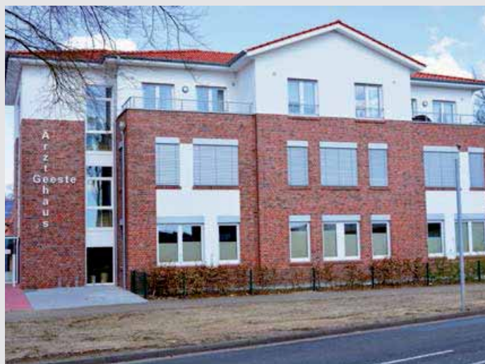
Das neue Ärztehaus Geeste stellt die medizinische Versorgung der gesamten Gemeinde sicher.
