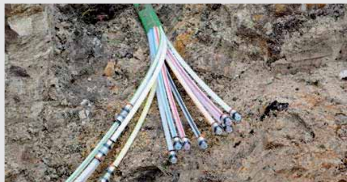
Ab 2019 sind ca. 95 % der Gemeinde mit Glasfaseranschlüssen für eine schnelle Internetverbindung versorgt.
