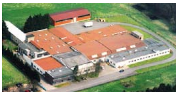
Firmenstandort stahlotec am Heideweg in Hagen a.T.W.
