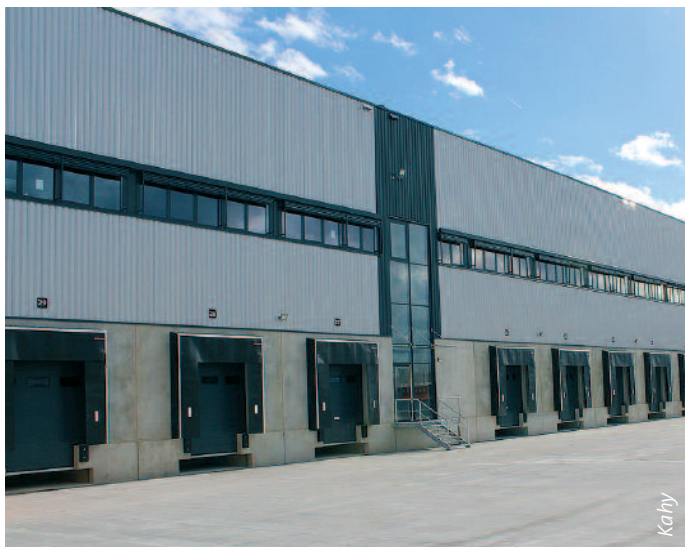
Das neue Logistikcenter im Industriegebiet von Schifferstadt wurde für einen großen international tätigen Automobilhersteller eingerichtet.
