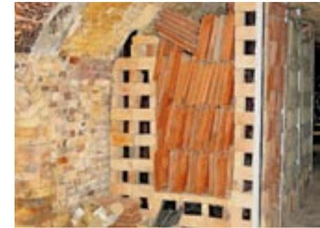
*Die Rekonstruktion zeigt einen Teil des 90 Meter langen Ringofens. Er wurde jahrelang ununterbrochen mit Kohle befeuert und konnte durch Luken von außen Stück um Stück geleert und neu befüllt werden.*
