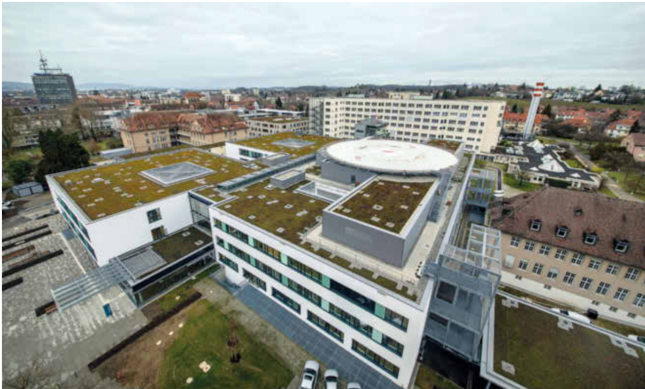
Der dreigeschossige Neubau des Klinikums Konstanz mit einem Hub-schrauberlandeplatz auf dem Dach.
