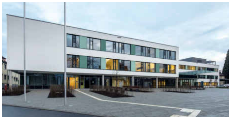
Der Eingangsbereich des Klinikneubaus. Er befindet sich im Konstanzer Stadtteil Petershausen.
