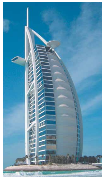
Burj al Arab. In dem berühmten Hotel und Wahrzeichen von Dubai sind TROX-Produkte verbaut.
