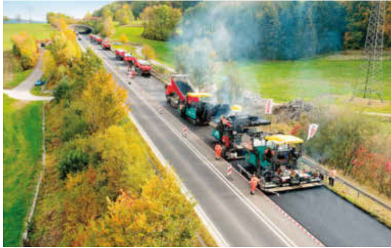
Eine Storz-Kolonne bei der Arbeit.
