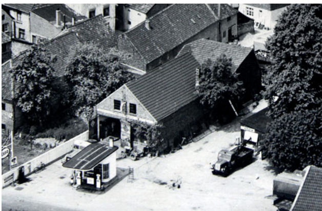
Der dritte Standort Ende der 40er-Jahre an der Venloer Straße.
