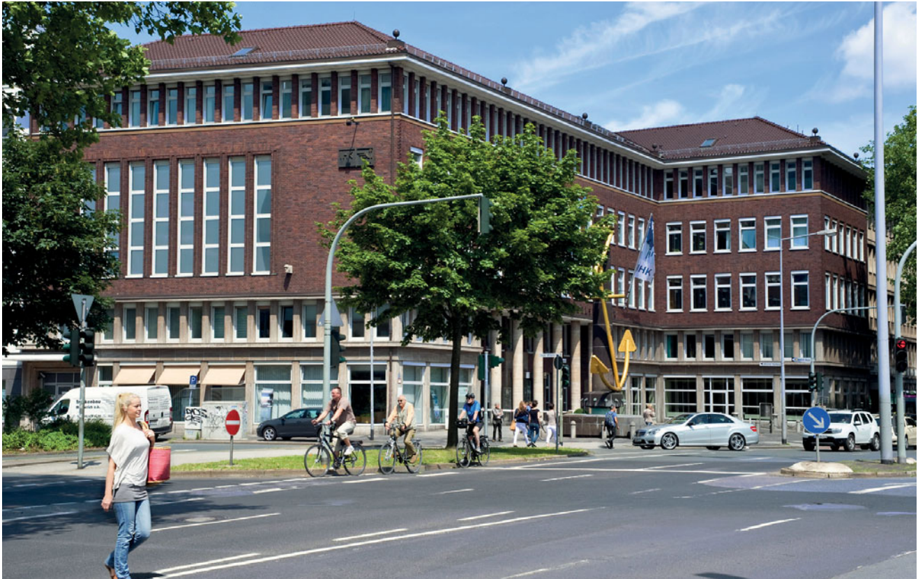
An den rechten Teil des Gebäudes schließt sich ein weiterer, von der IHK 1996 erworbener Trakt (Mercatorstraße 16-20) an, wo heute der Geschäftsbereich Bildung und Technologie und der Bereich IT untergebracht sind. Daneben gibt es eine Reihe Sitzungs- und Besprechungsräume.
