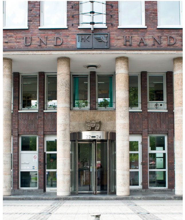
Aus städtebaulichen Gründen unter Berücksichtigung des Denkmalschutzes sind auch am Portal nur behutsame Anpassungen vorgenommen worden.
