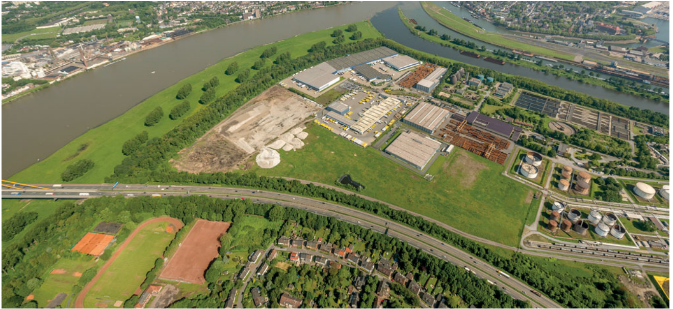
Auf der Brache in unmittelbarer Autobahnnähe entsteht das neue VW-Logistikzentrum.
