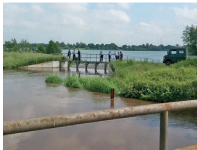
Hochwassernotentlastung durch die Flutung des Baggersees in Werth
