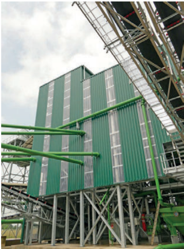
Das komplette Kieswerk: Die neue, grün eingehauste Aufbereitungsanlage befindet sich in der Mitte.
