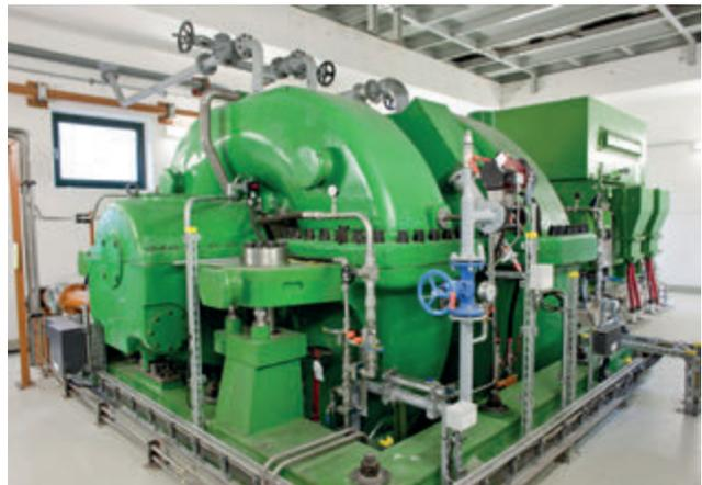
Gutes Beispiel für Energieeffizienz bei Thyssen-Krupp Steel Europe: Die modernisierte Entspannungsturbine am Hochofen 8 erzeugt etwa 30 000 Megawatt Strom pro Jahr. Foto: © thyssenkrupp AG
