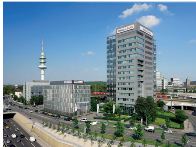
So soll das Targobank Quartier nach seiner Fertigstellung aussehen.
