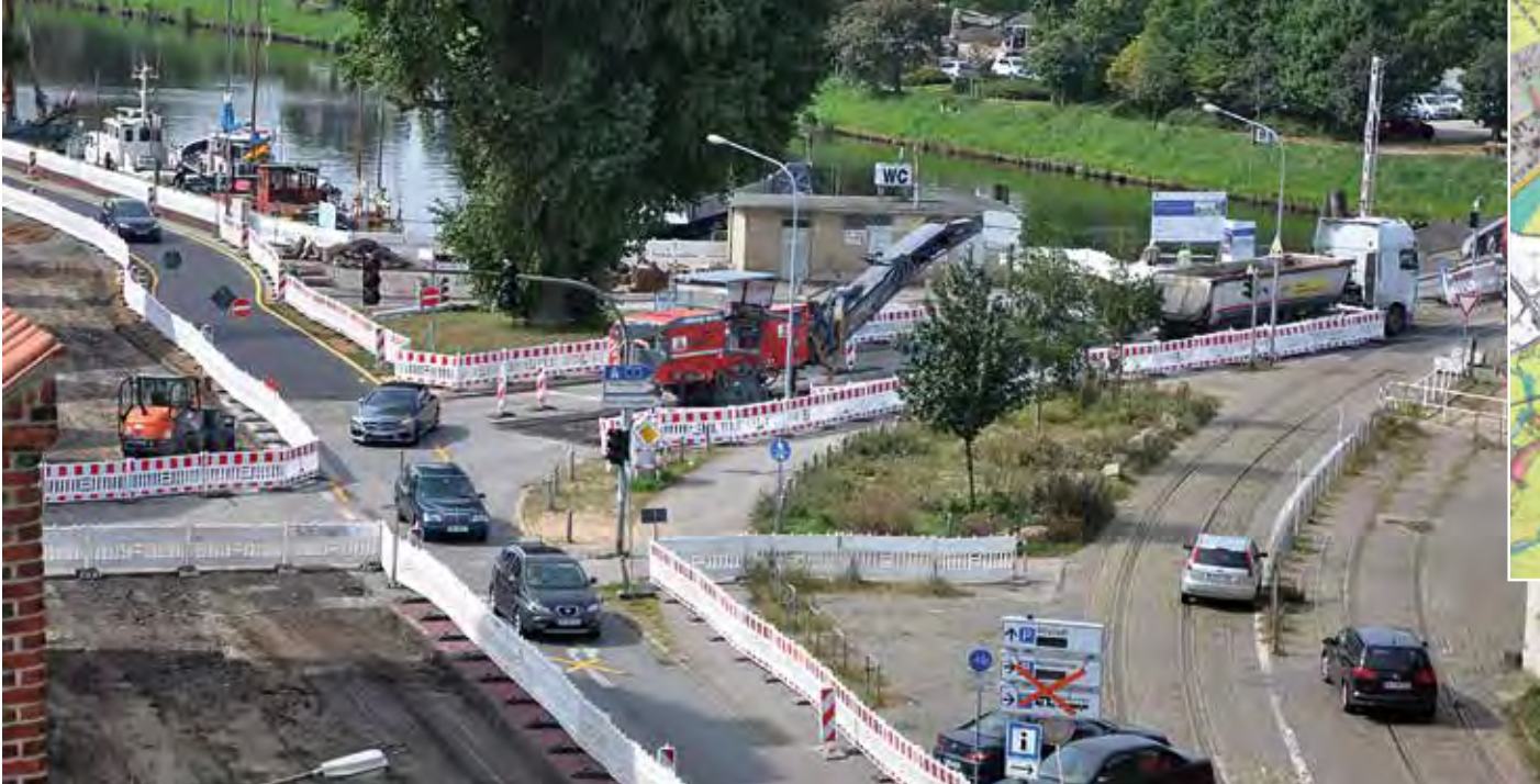
Bild links: die Baustelle An der Untertrave/Drehbrückenplatz in Lübeck; Bild rechts: Bausenatorin Joanna Glogau
