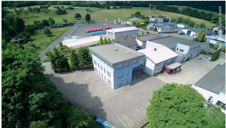
Die Firmenzentrale der Dornburger Pinguin-System GmbH.
