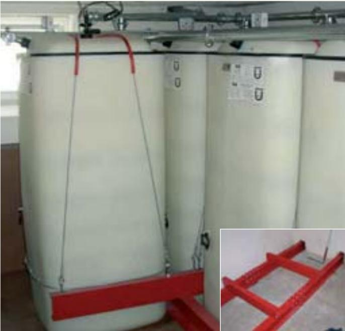
Beispiel für die Aufstellung einer hochwassersicheren Heizöllageranlage. Da der Boden in diesem Beispiel die Lasten nicht aufnehmen kann, werden die Stützen in der Wand verankert.
