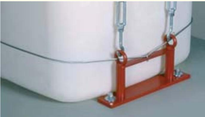
Detailansicht der Standardausführung der Fixierung gegen Auftrieb und seitliches Verrutschen. Hier ist der Boden in der Lage, die auftretenden Lasten aufzunehmen.
