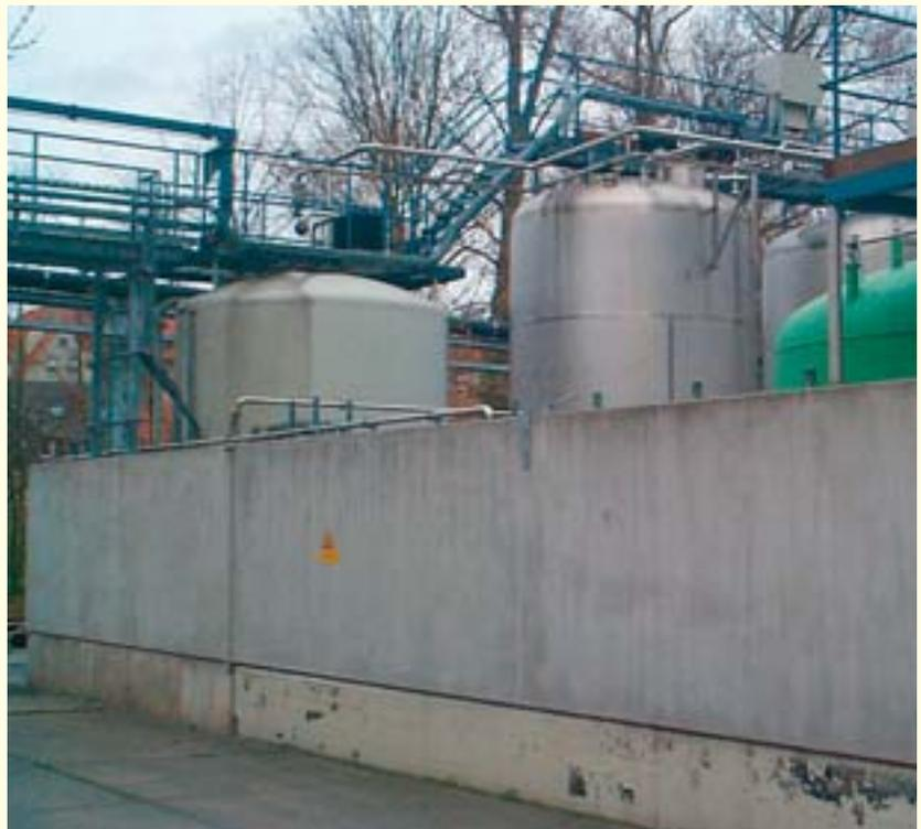
**Im Freien aufgestellte Lagerbehälter für wassergefährdende Stoffe sind mit einer ausreichend hohen Schutzmauer umgeben.**
