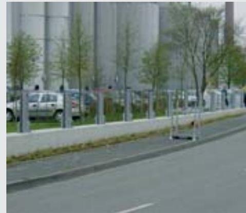
Errichtung eines Dammbalkensystems zum Schutz einer Industrieanlage.
