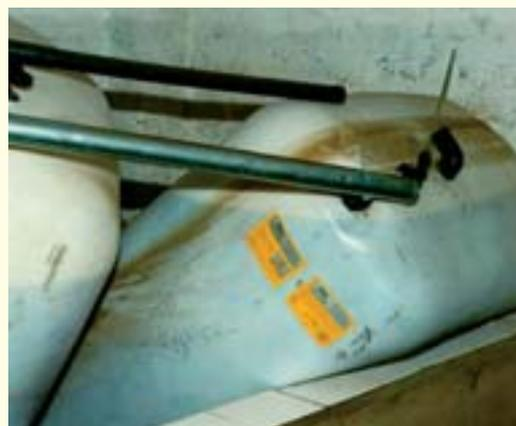
**Ungeeigneter Heizöltank nach einem Hochwasserereignis.**
