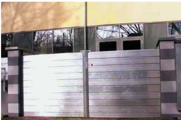
Hochwasserschutztor mit Dambalken
