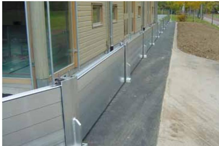
Umlaufender Hochwasserschutz mit teilmobilen Schutzelementen
