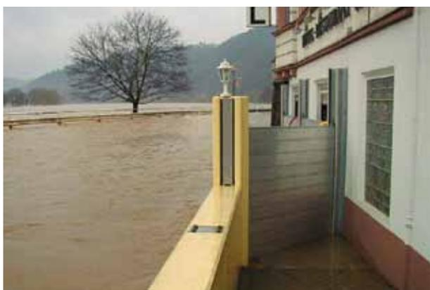
Umlaufender Hochwasserschutz mit teilmobilen Schutzelementen
