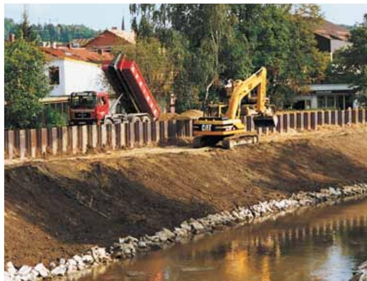
Hochwasserschutzwand mit Stahlspundwand im Bau
