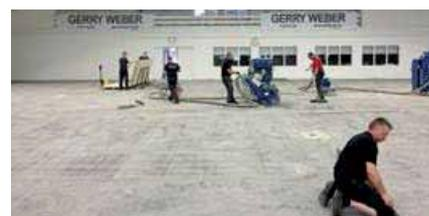
Fräs- und Schleifarbeiten, Kugelstrahlen in einer Tennishalle
