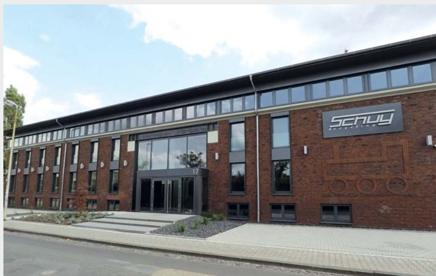
Das neue Verwaltungsgebäude der Schuy Recycling: Die umfangreichen Umbau- und Renovierungsarbeiten an der ehemaligen Eisenbahnmeisterei wurden im Februar 2017 fertiggestellt.
