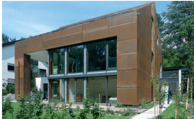
Cortenstahl mit feiner gewollter Rostpatina ist für Fassaden und im Innenausbau auf dem Vormarsch und sorgt für einzigartige Optik.
