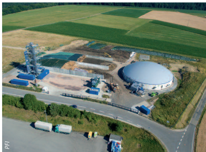
Biogas- und Power-to-Gas-Anlage im Energiepark Pirmasens-Winzeln
