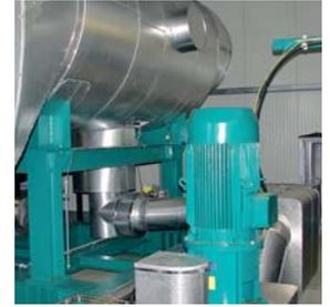
Die für den ORC-Prozess verwendeten organischen Flüssigkeiten haben einen deutlich niedrigeren Siedepunkt als Wasser, so dass unter hohem Druck der Verdampfungsprozess auch bei geringeren Temperaturen ablaufen kann.
