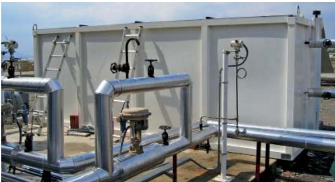
Abb. 28: Latentwärmespeicher in Almería
