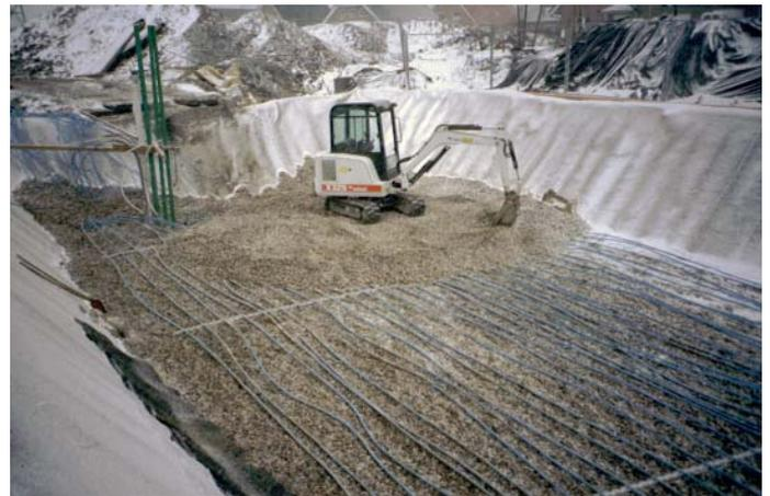
Abb. 40: Im Bau befindlicher Kies-Wasser-Speicher mit Kunststoff-Wärmeübertragungsrohren
