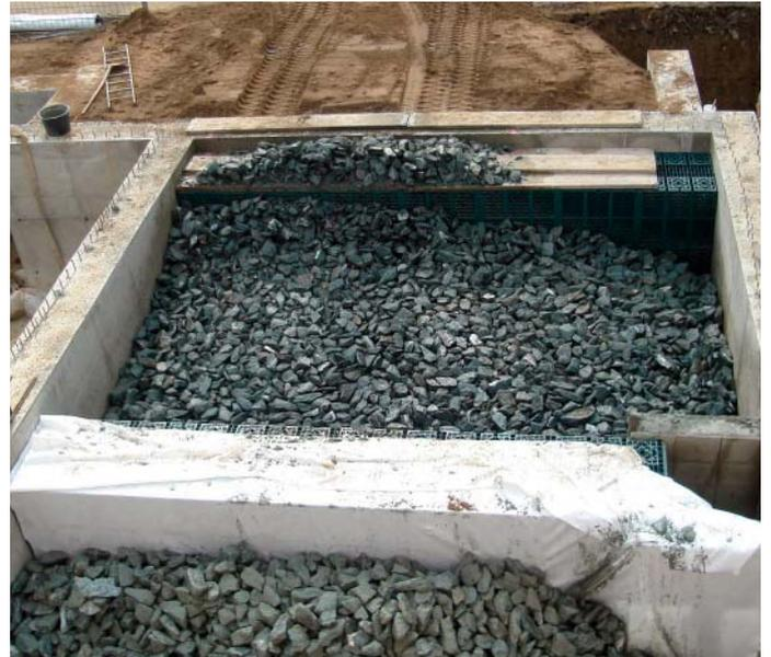
Abb. 43: Schotterspeicher im Bau
