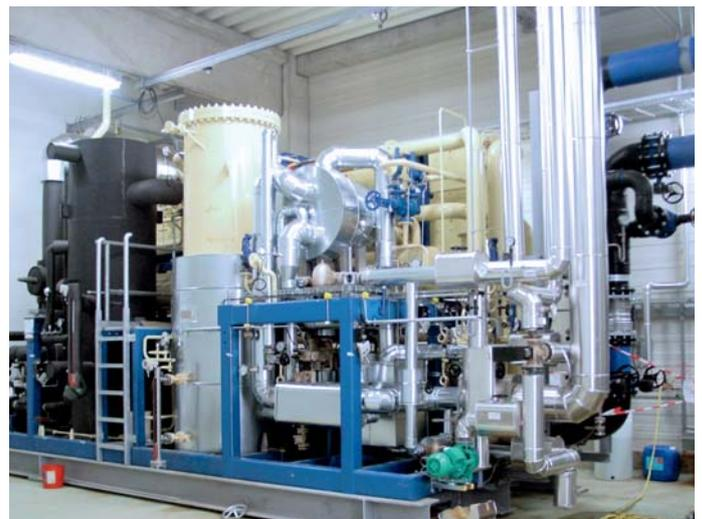
Abb. 59: Absorptionskältemaschine
