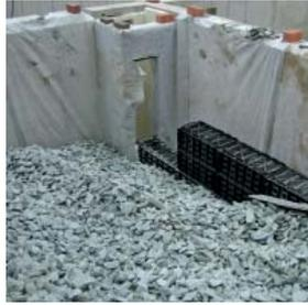
Der Schotterspeicher ist in Form eines Quaders aufgebaut, wobei an den Stirnseiten jeweils Luftverteilersysteme installiert sind, in welche die Luft ein- bzw. austritt. Als Speichermaterial wird relativ grober Schotter verwendet (Korngrößen 45–150 mm), sodass der Druckabfall der durchströmenden Luft nicht zu groß ist. Der schematische Aufbau ist in Abbildung 42 dargestellt.
