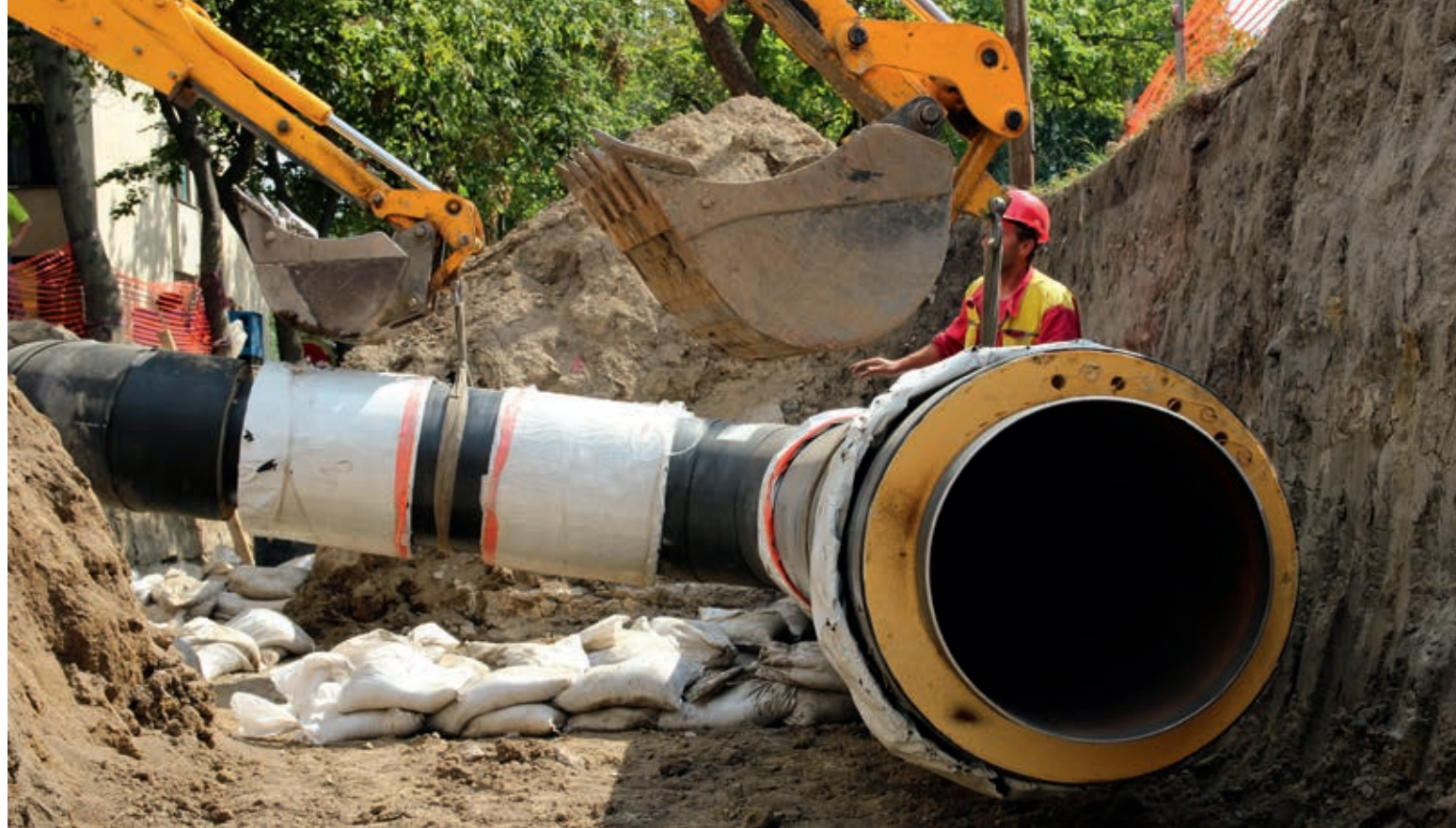
Absenken einer großen Wärmeleitung (Bild: iStock by Getty Images)
