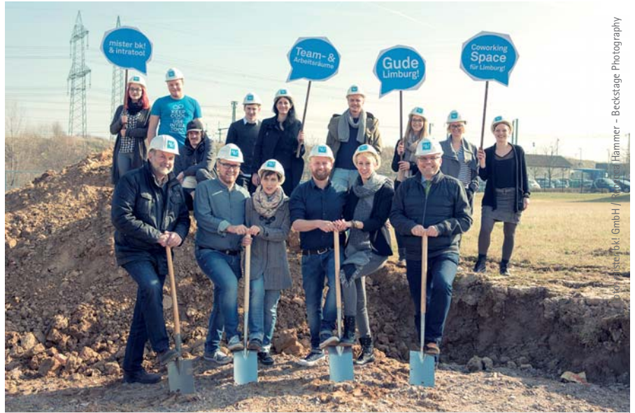
Den Spatenstich für den Neubau im ICE-Gebiet feierten die Inhaber und das Team der Firma mister bk! mit Bürgermeister Dr. Marius Hahn und Markus Wirth vom Ingenieurbüro Wirth aus Dietkirchen.
