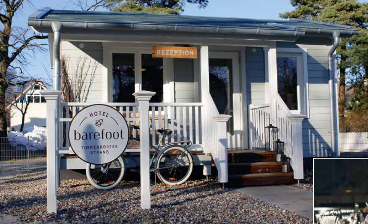
Bild links: Barefoot Konzepthaus in Timmendorfer – Anlaufstelle während der Umbauarbeiten; Bild unten: Hotelier Til Schweiger
