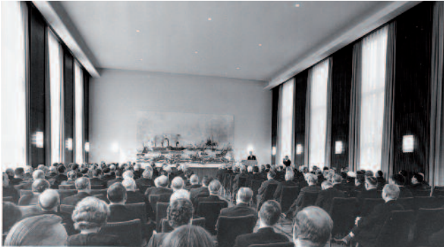
1965: Der Erweiterungsbau der IHK Bremerhaven wird eröffnet.
