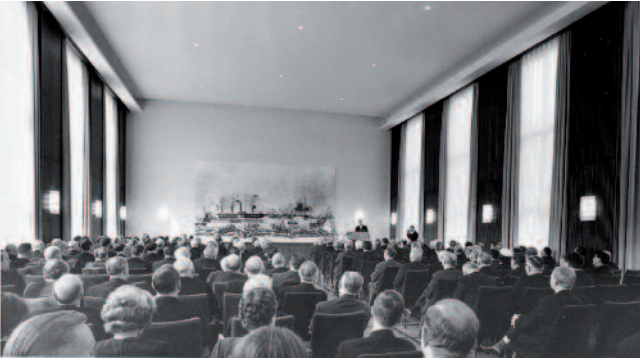
1965: Der Erweiterungsbau der IHK Bremerhaven wird eröffnet.
