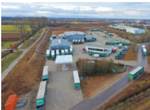
Der neue Standort der Friedrich Wildt GmbH in Ettenheim.
