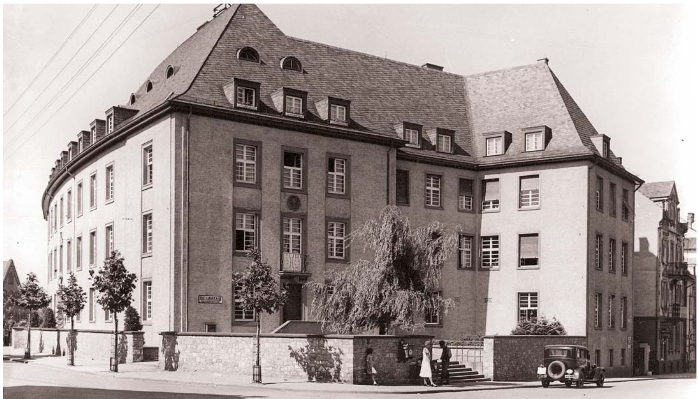
Das neue Limburger Kreisbauamt an der Schiede, Ecke Diezer Straße kurz nach der Eröffnung im Oktober 1926. Auch die Kreissparkasse Limburg und die IHK Limburg sind hier untergebracht (StA LM)
