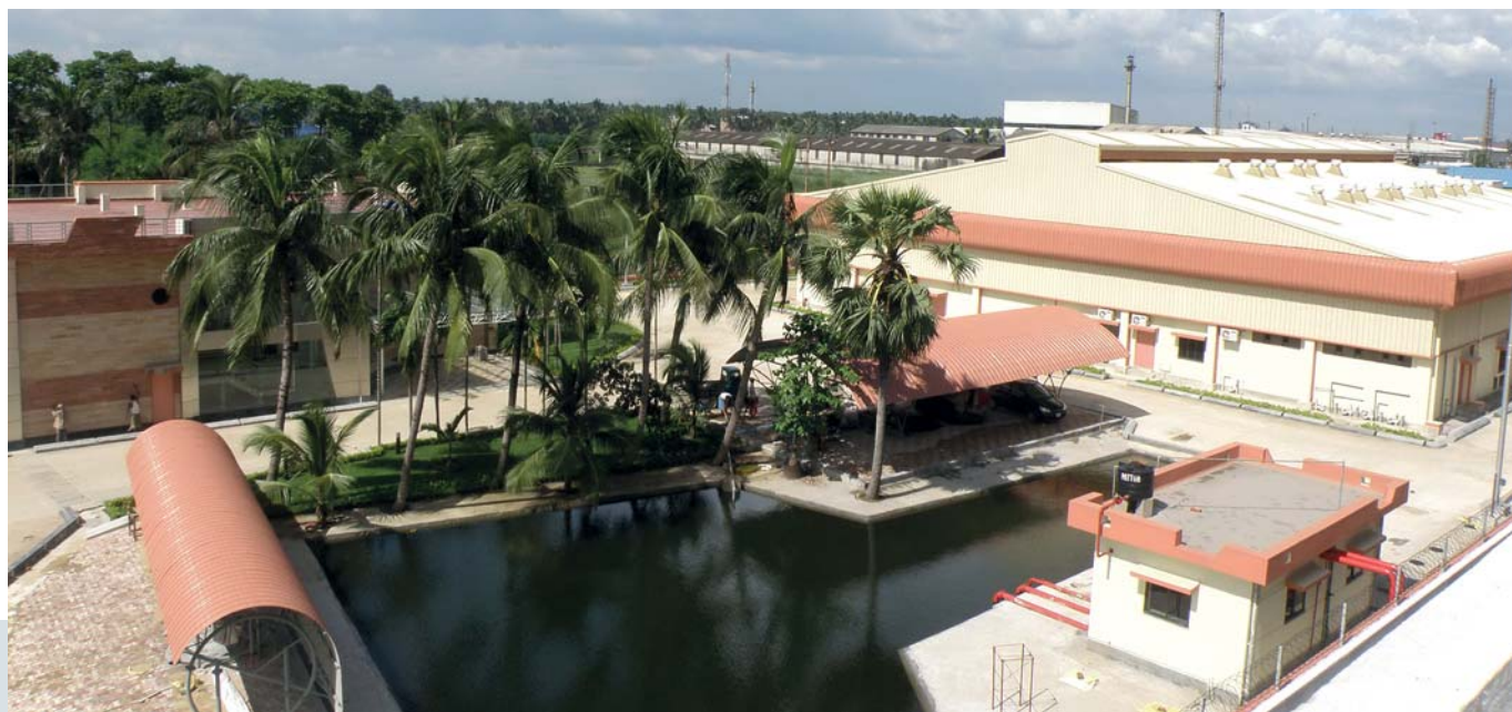
Das Labor- und Verwaltungsgebäude der von der Weilburger Coatings neu eröffneten Produktionsstätte in Indien (Weilburger Coatings)
