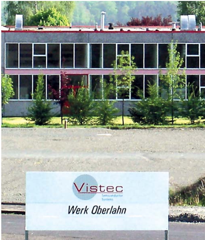
Die „Visitenkarte“ der Vistec Semiconductor Systems GmbH vor der Halle kündigt bereits von dem neuen Besitzer (Foto: Wolfgang Hens)
