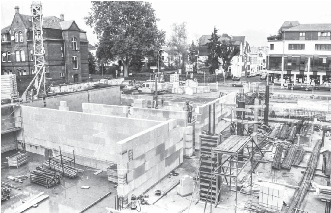
Einige Kinosäle sind im linken Teil der „Cineplex“-Baustelle schon deutlich sichtbar. Rechts neben den Mauern wird sich später einmal das Foyer befinden (Fotostudio Sascha Braun)
