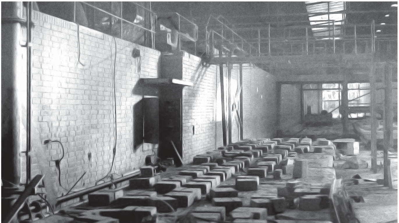
Das Ziegelwerk der Bott-Eder GmbH in Oberbrechen an der Hessenstraße nach seiner Stilllegung, November 1965 (Foto: Ulrich Eisenbach/HWA)
