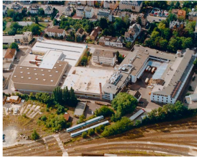
Die Blechwarenfabrik will ihren bisherigen Standort zwischen Bahnlinie und Diezer Straße aufgeben (Blechwarenfabrik Limburg GmbH)
