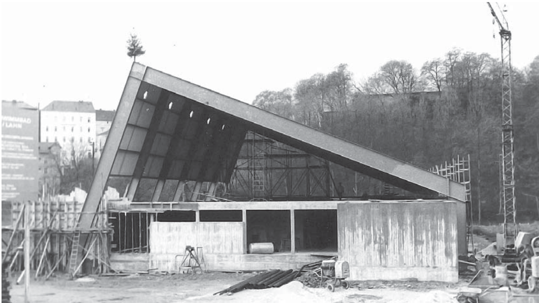
Bau des Weilburger Hallenbades, 30.4.1970 (BuSm WB)
