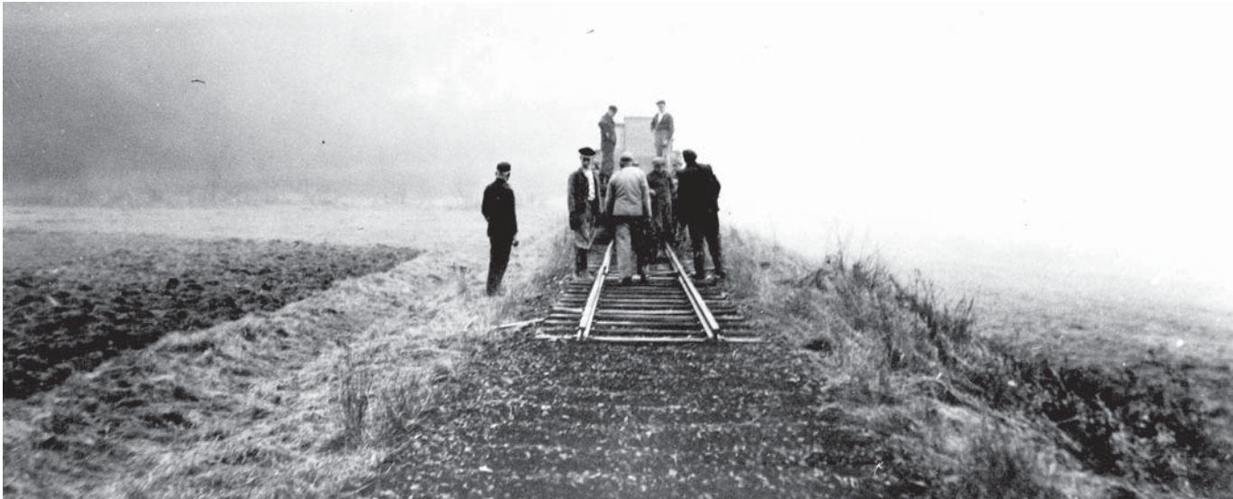
Rückbau der Eisenbahnstrecke zwischen Hofen und Eschenau, 1961 (HWA)
