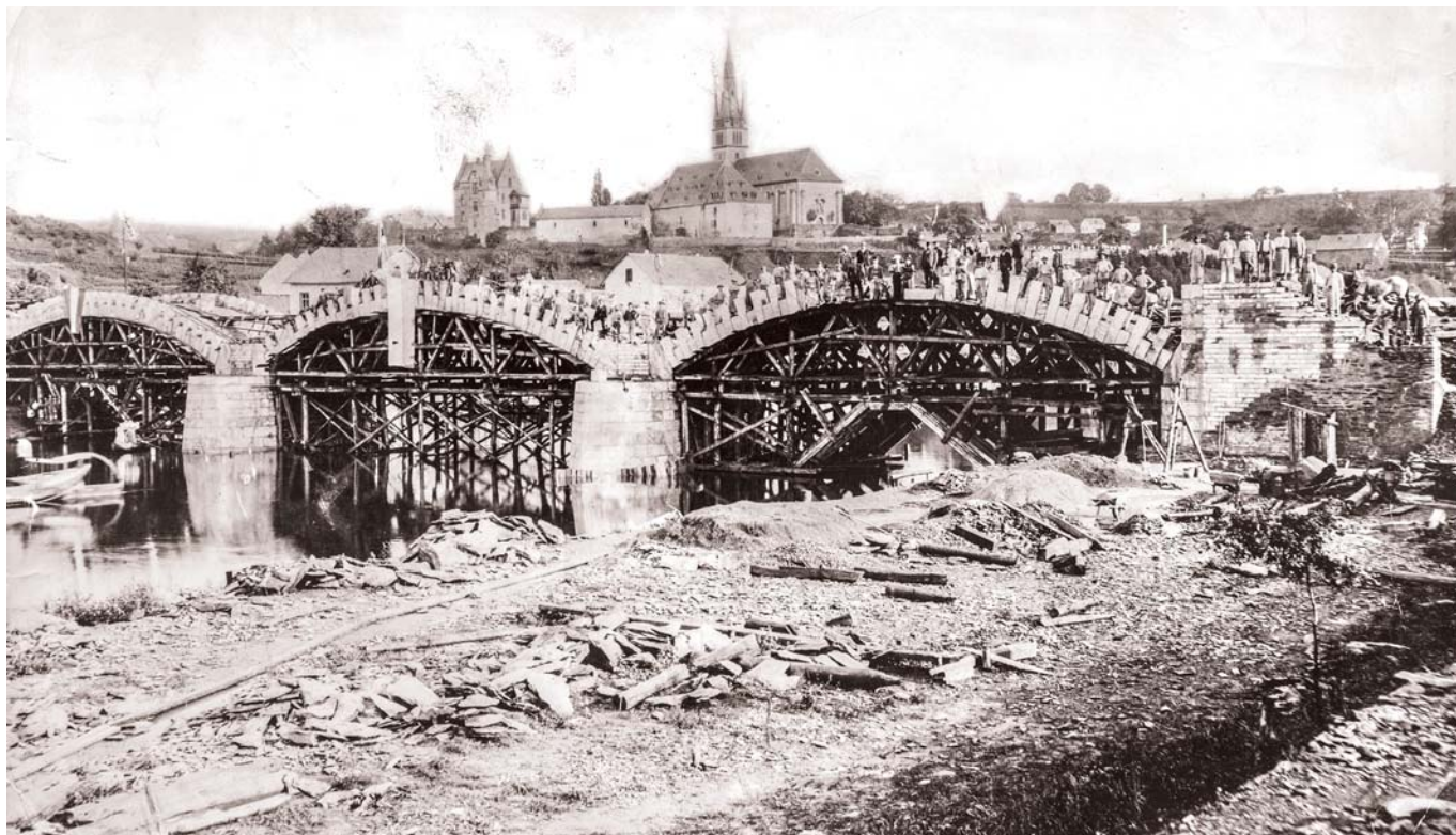
Bau der Lahnbrücke in Villmar, 1895 (Mz LW)
