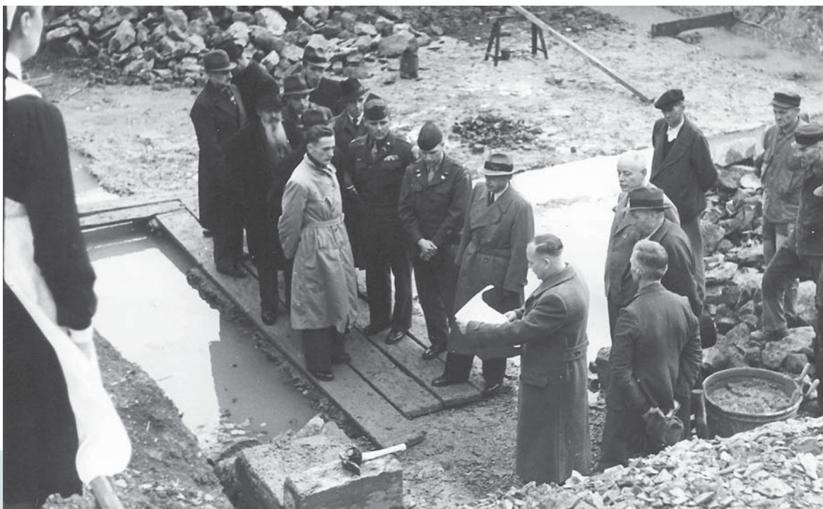
Grundsteinlegung für den Erweiterungsbau des Kreiskrankenhauses in Weilburg, Oktober 1947 (Foto: W. Weber, Weilburg/BuSm WB)
