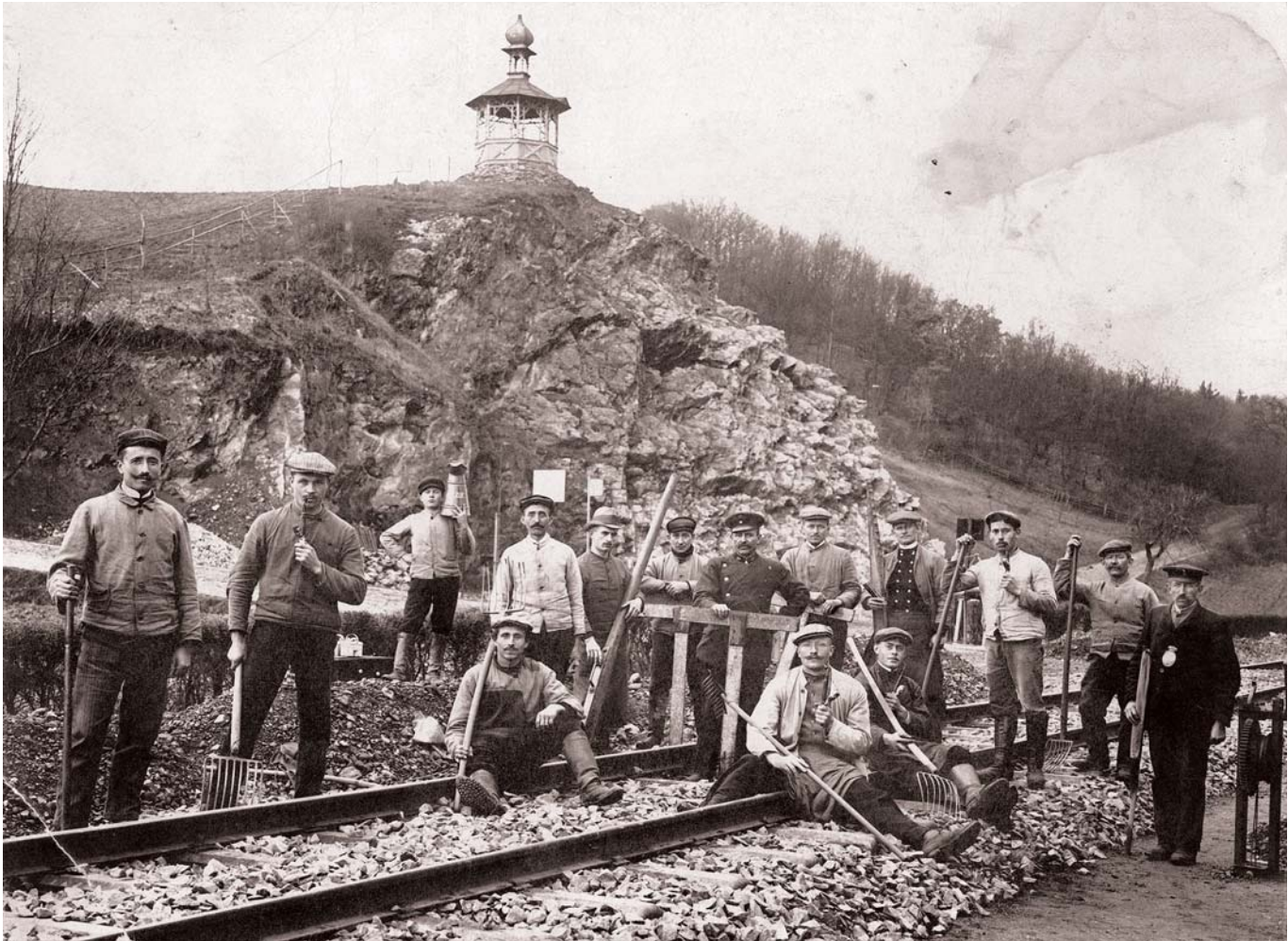
Zweigleisiger Ausbau der Strecke Eschhofen – Höchst a.M. Arbeitstrupp am Aussichtstürmchen in Niederselters, 1912 (GA Niederselters)
