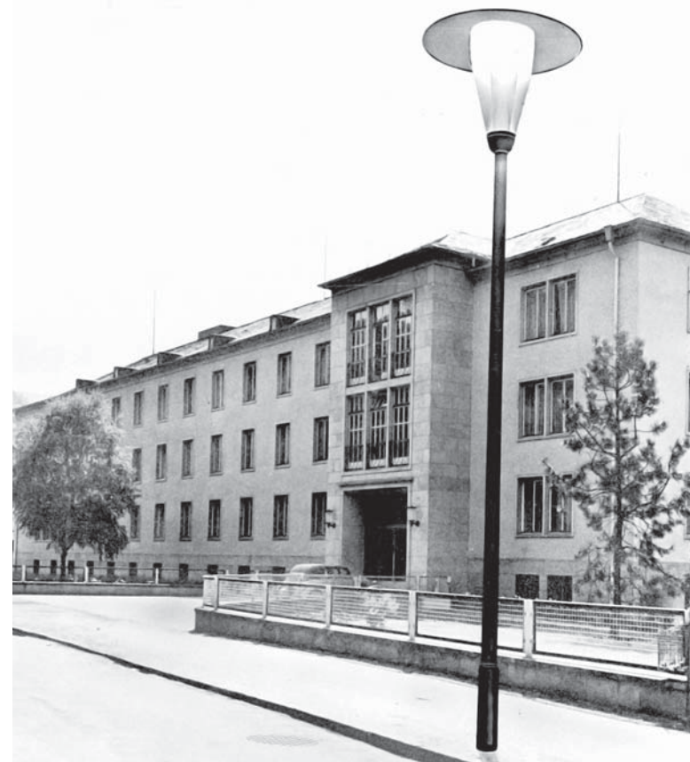
Verwaltungs- und Fabrikgebäude der Körting & Mathiesen AG in der Holzheimer Straße in Limburg, Juni 1955 (Foto: Walter Stöppler, Limburg/HWA)
