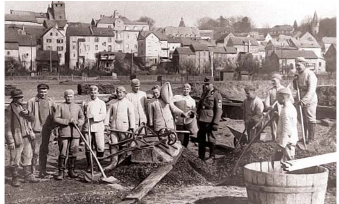
Trupp des Reichsarbeitsdienstes beim Bau des Emsbach-Stufenkraftwerks in Camberg, 1937 (StA BC)
