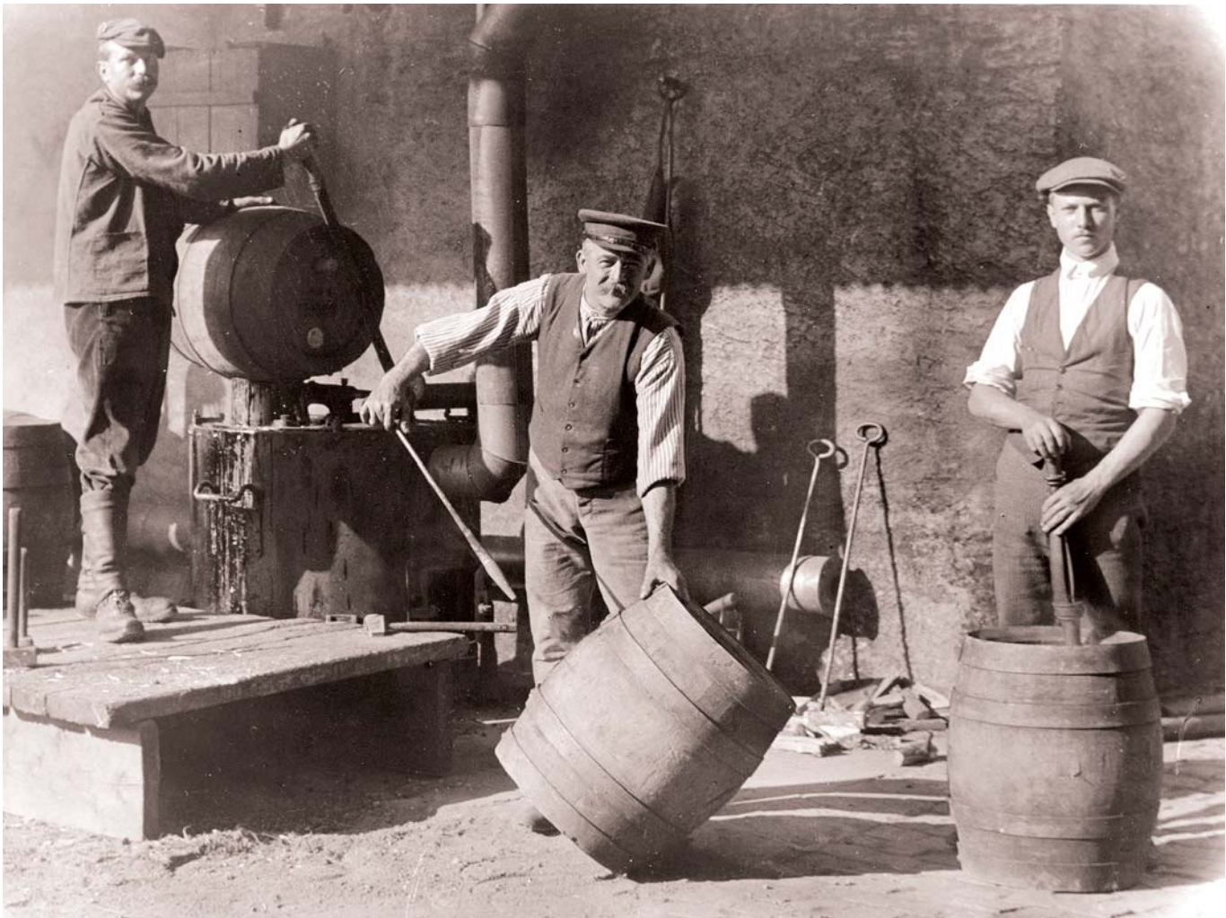
Ausbesserung von Fässern in der Brauerei Heinrich Göbel in Niedershausen, um 1910 (HWA)
