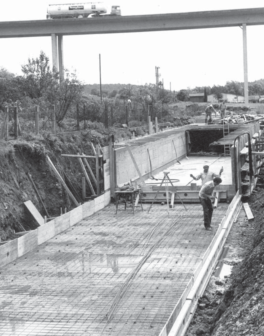
Die Brücke über das Kerkerbachtal im Sommer 1961 (Mz LW)
