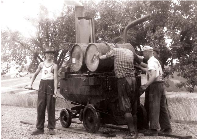
Arbeitskolonne der Baufirma Wilhelm Schütz bei Straßenbauarbeiten, vermutlich 1930er Jahre (Wilhelm Schütz GmbH & Co. KG)
