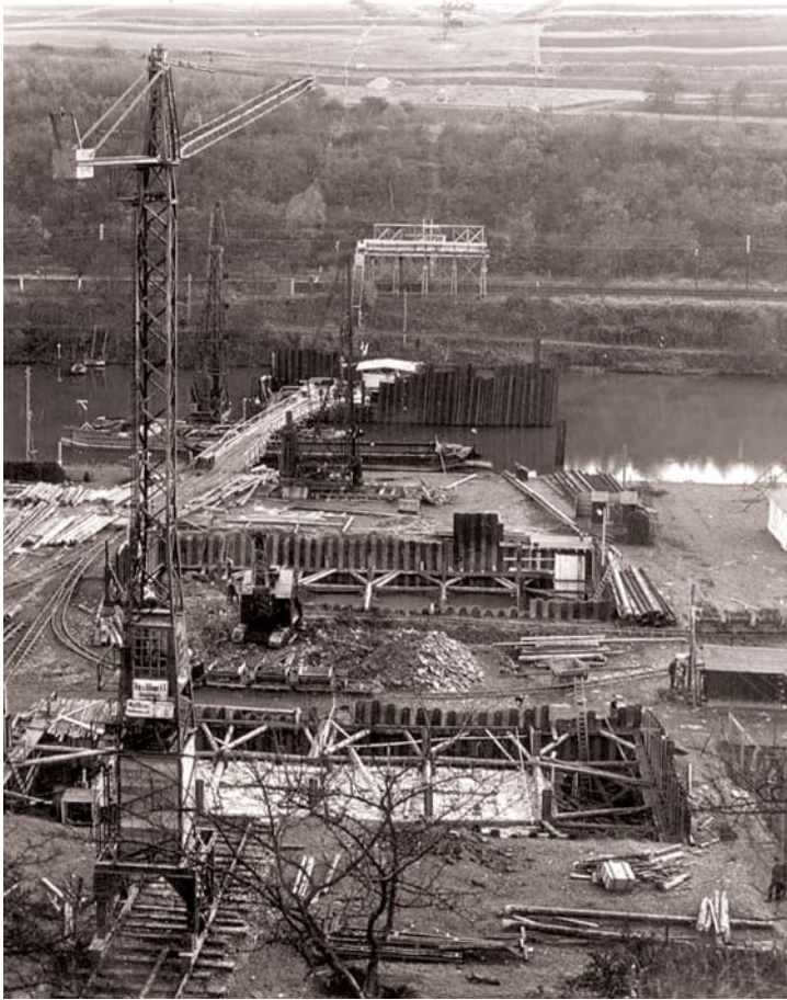
Beginn des Baus der Autobahnbrücke bei Limburg, 1937 (StA LM)
